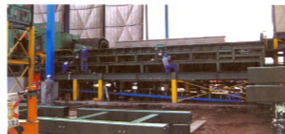
原木立送りコンベヤ 試運転調整
